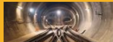
Stavby železničních tratí
